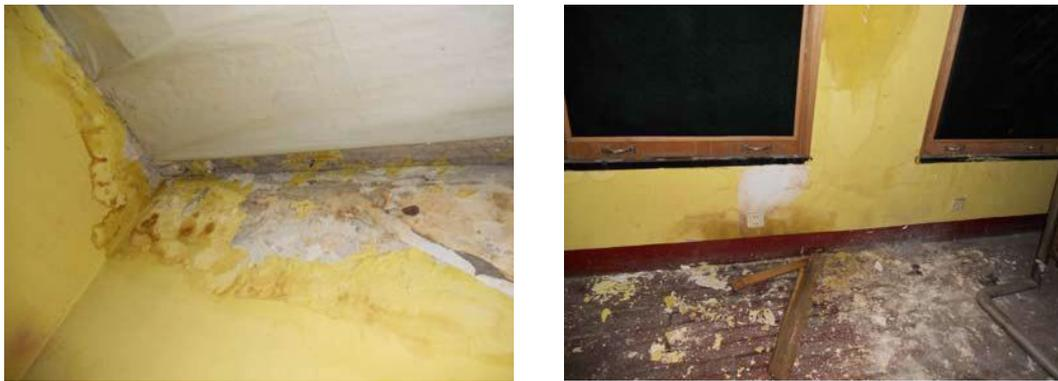
图 4-9 a&b 围护墙体开裂渗水现象
