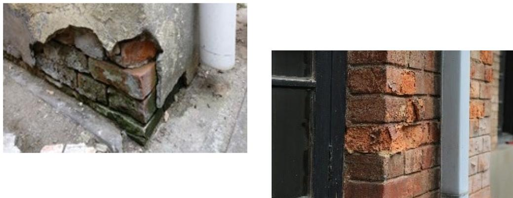
图7-1 砖墙基础砖块腐蚀、粉化
