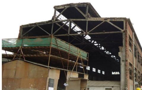
图 3-3 某近现代建筑钢筋混凝土屋架
