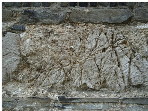
图 3-1 砖石混砌外墙中石灰岩（青石）及典型的刀砍状溶蚀
