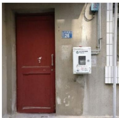
图 7-5 燃气系统明管明路铺设
