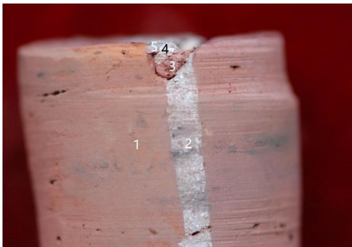
图 3-2 某近现代建筑砌筑灰浆及历次修复记录
