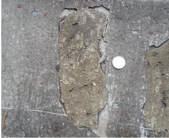
图 3-14 采用有机树脂修建于 20 世纪 20 年代的石材，短时间内石材出现新的病害
