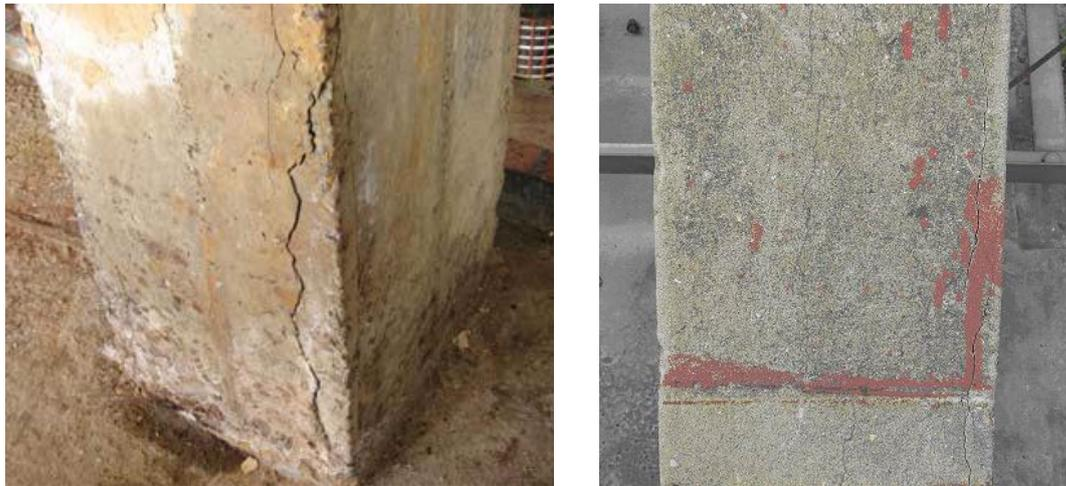
图 4-7 a&b 混凝土构件开裂现象
