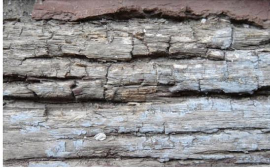
图 3-12 室外木质栏杆扶手腐朽
