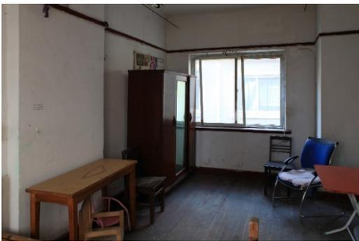
图 7-7 近现代室内木质电线槽
