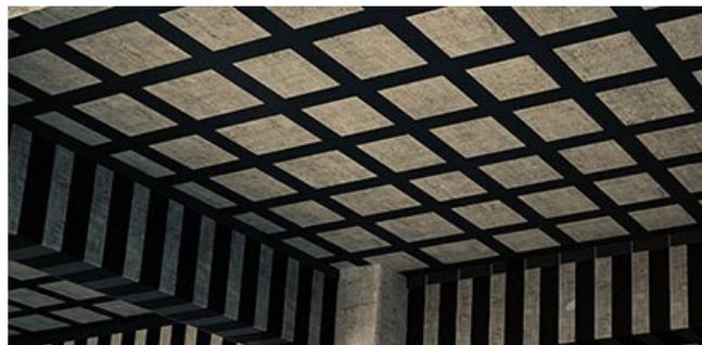
图 4-11 粘贴碳纤维布加固混凝土板
