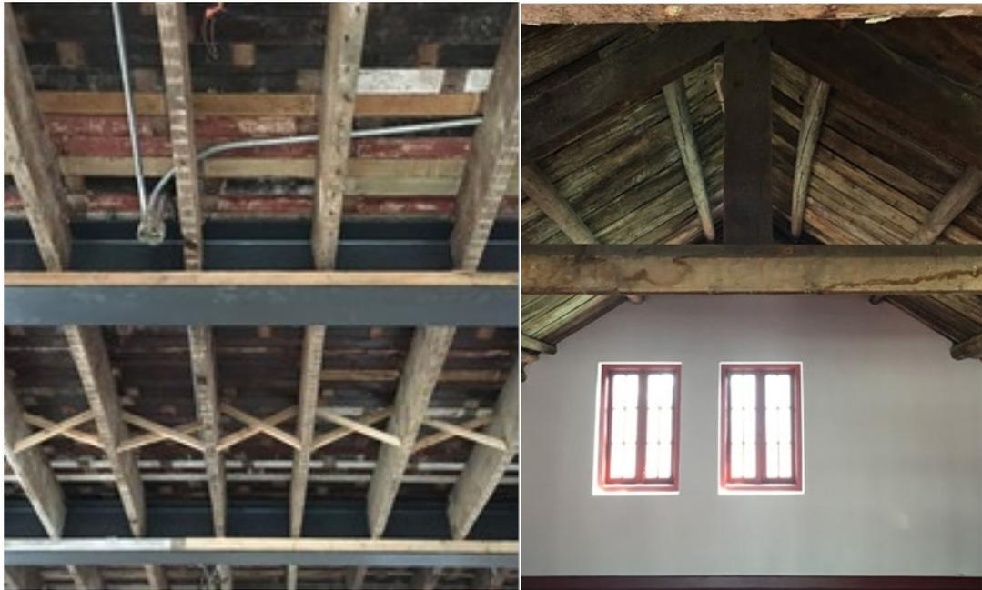
图 4-31 木楼盖修缮照片图 图 4-32 木屋架照片
