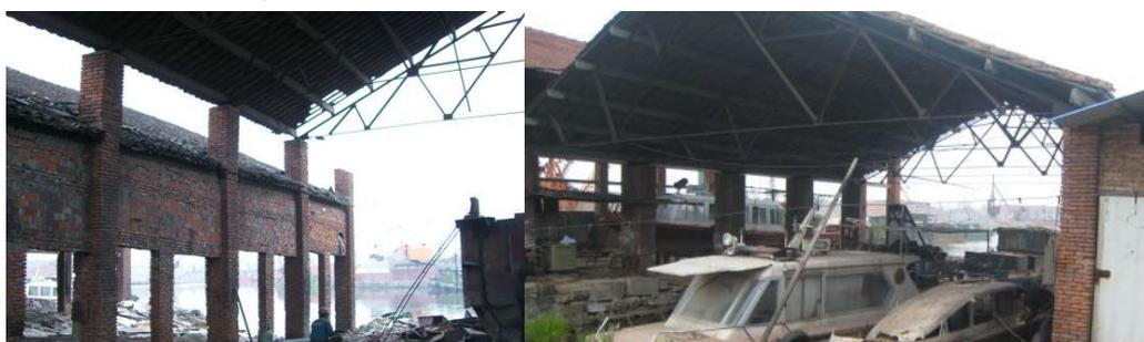
图4-60 钢屋架破损老化实例图
