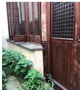
图 3-10 嵌于墙内木柱腐朽
