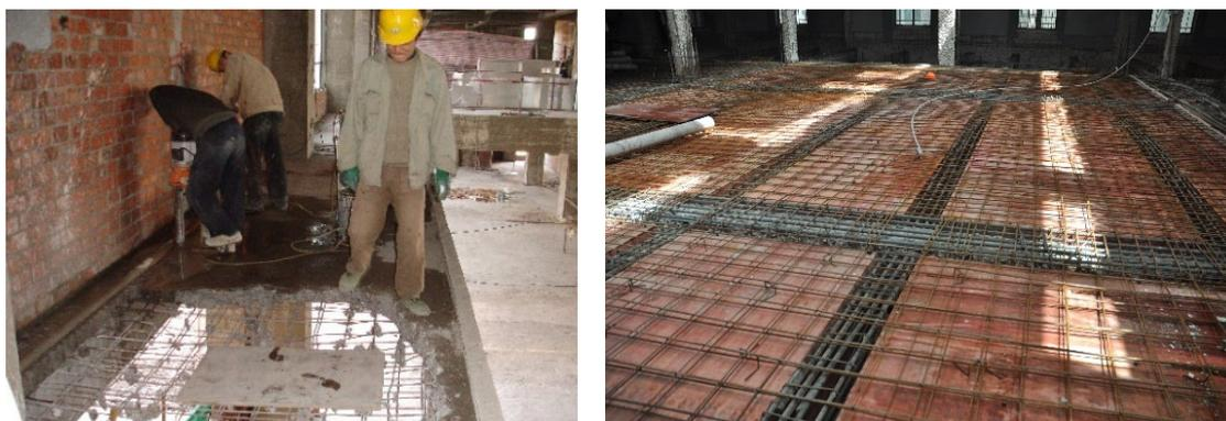
(a) 无损切割混凝土板 (b) 浇筑混凝土板
