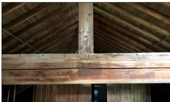
图 3-9 木桁架开裂、局部变色、腐朽、虫蛀等
