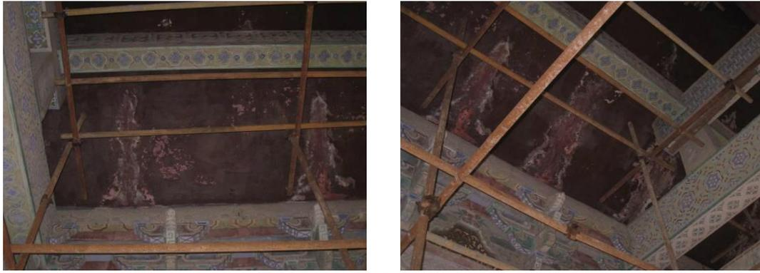
图 4-8 a&b 屋面板开裂渗水现象
