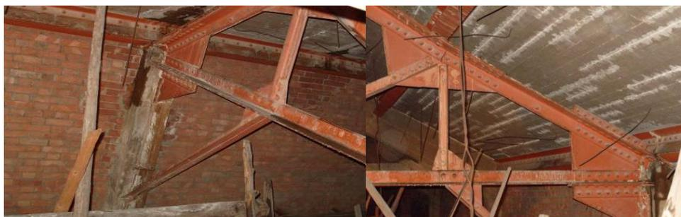
图4-59 钢屋架腐蚀实例图
