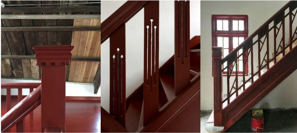
图 6-39 楼梯栏杆、望柱详图及照片
